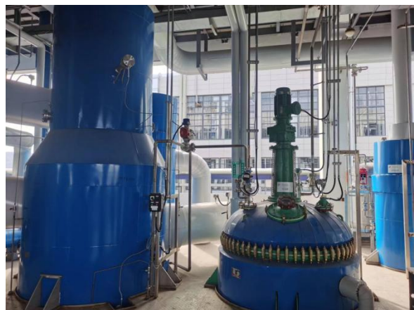
MVR脱盐装置
