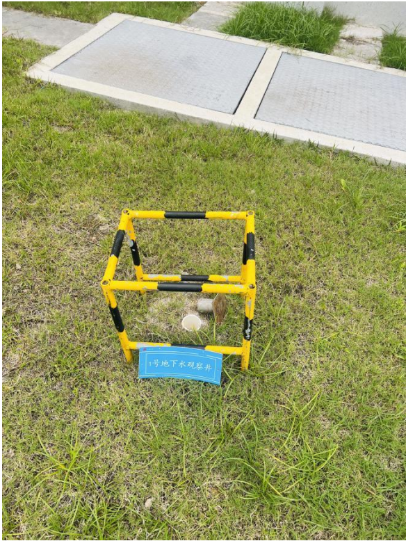
厂区1号地下水监测井
