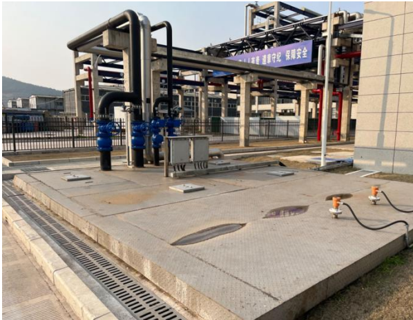
初期雨水收集池（厂区南面）
