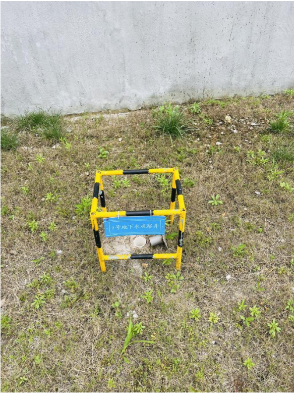
厂区2号地下水监测井
